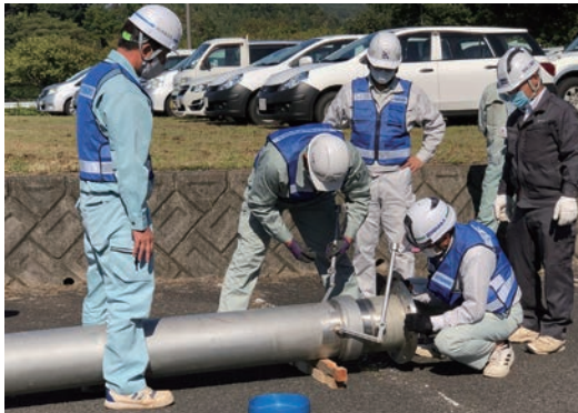
管路応急復旧訓練
