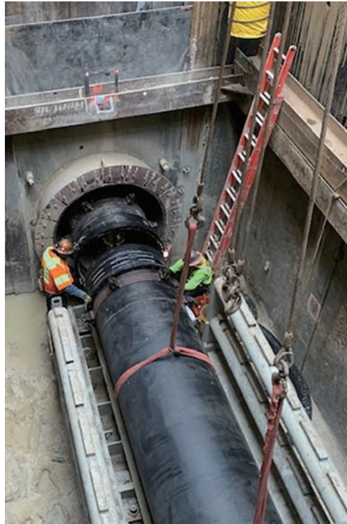
海外初の S 形さや管推進工事
