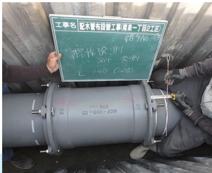
行橋市上水道課(福岡県) GX形 呼び径 350
