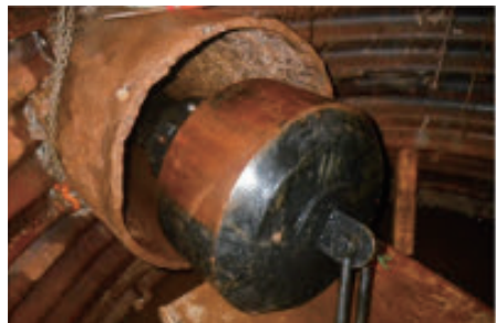
写真5 模擬管調査状況
