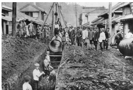
配水管（36 インチ 鑄鉄管）布設工事
