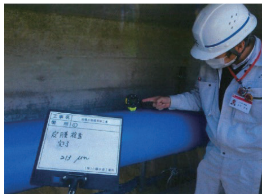
写真8 現地塗装完了後の塗膜厚検査状況
