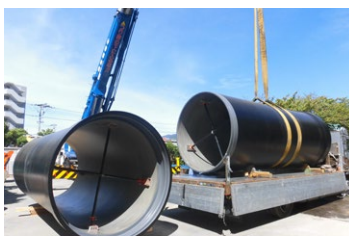
耐震性貯水槽移設工事
