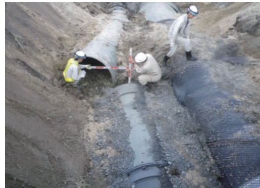
図8 曲管部の移動に伴う管の離脱
