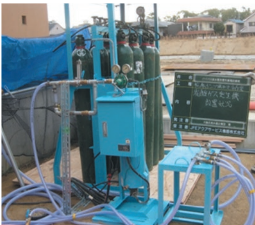
写真3 炭酸ガス注入装置
