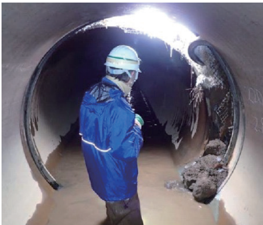
図6 継手の離脱とねじれ
