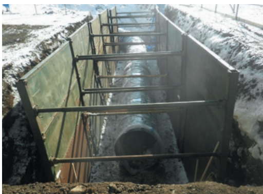
写真5 ダクタイル鉄管布設完了状況
