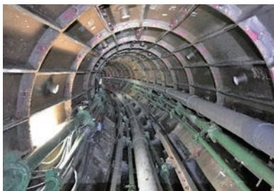
掘削が進むシールドトンネル
