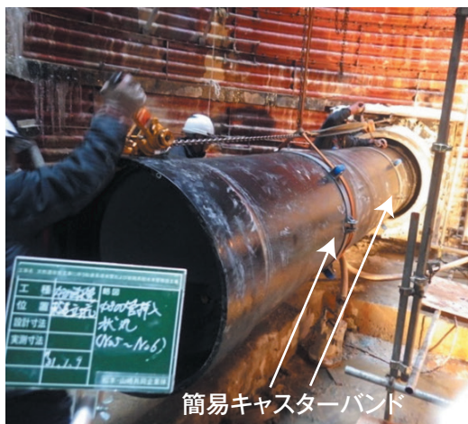
写真4 φ800PN形さや管内挿入状況
