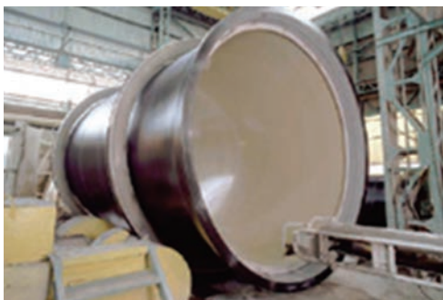
モルタルライニング施工状況
