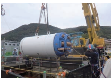
本市初の水道用鞘管シールド工法
