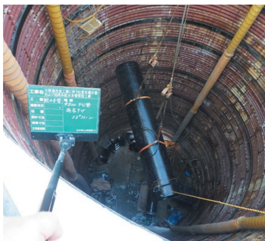
写真3 発進立坑内PN形管吊り降ろし
