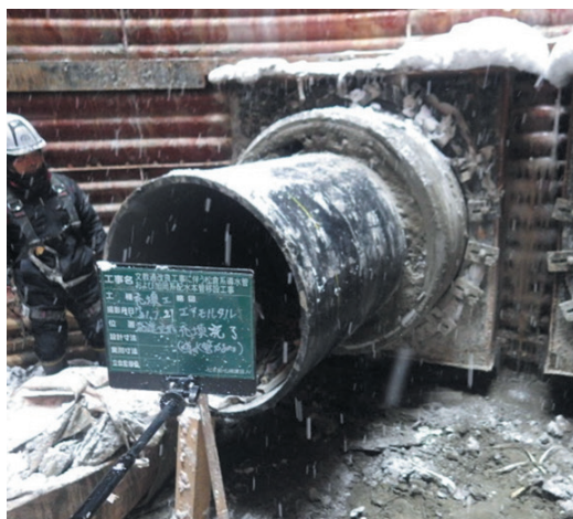
写真5 エアモルタル充填完了
