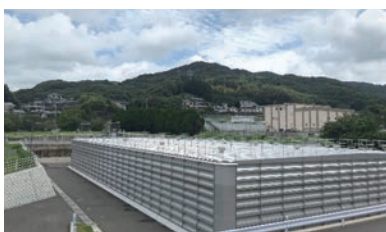
更新した山の田浄水場と配水池
