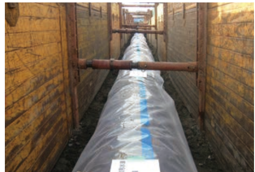
写真3 ダクトイル鉄管布設完了状況
