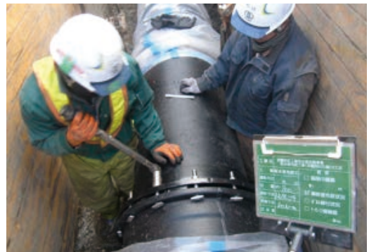
写真2 ダクトイル鉄管接合状況
