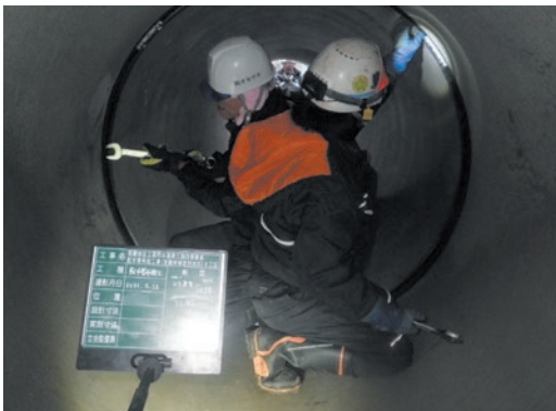
写真4 ダクタイル鉄管接合状況
