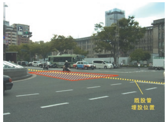
写真5 立坑設置予定箇所(No.4)
