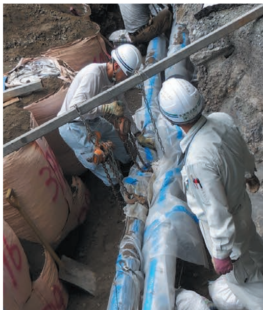
写真4 管の吊り上げ状態と土嚢設置
