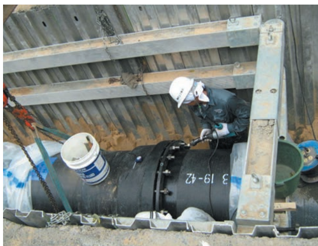
写真1、2 北部福岡緊急連絡管 呼び径900 S形ダクタイル鉄管布設状況
