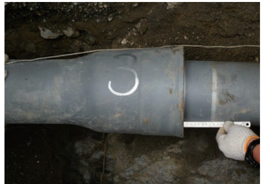
写真3 計測状況(継手の測定)
