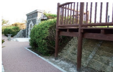
旧床几山配水池再整備（展望台設置）
