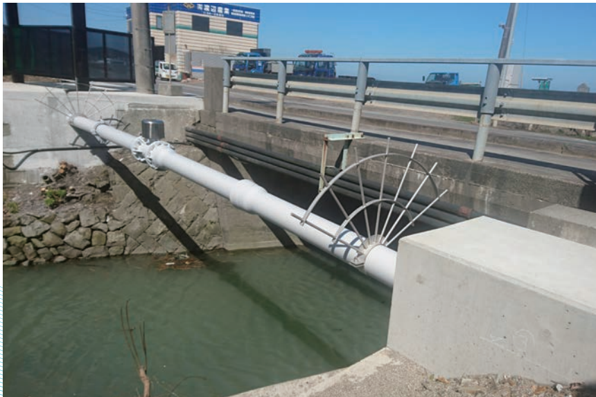
熊本県 天草市水道局水道課 FGX 形水管橋 呼び径 200
