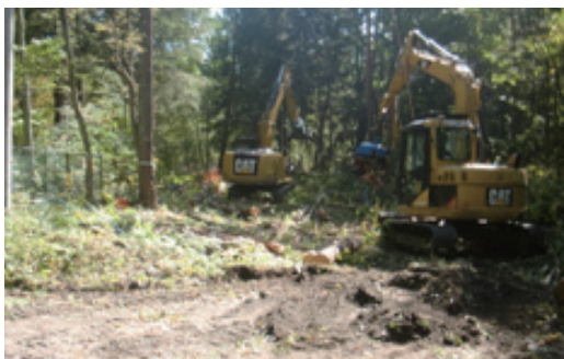
写真2 国有林野伐採状況
