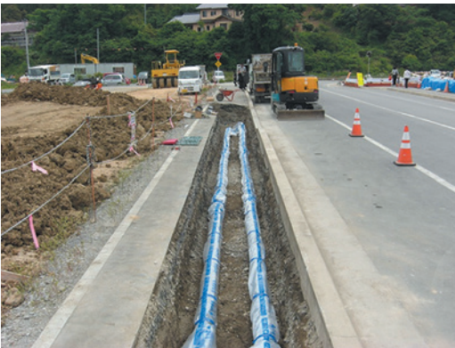
写真5 送・配水管布設状況
