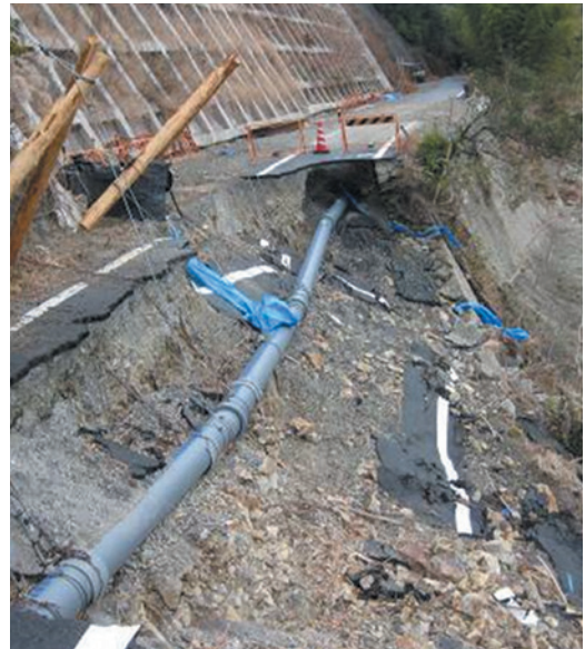
写真3 管路の状況(φ250 GX形)
