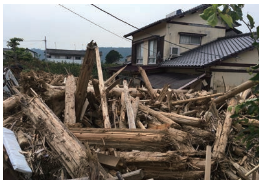
住宅地に押し寄せた流木（福岡県朝倉市）
