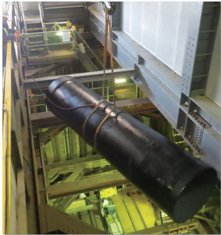
堺市上下水道局 PN形（持込工法） 呼び径 1000
