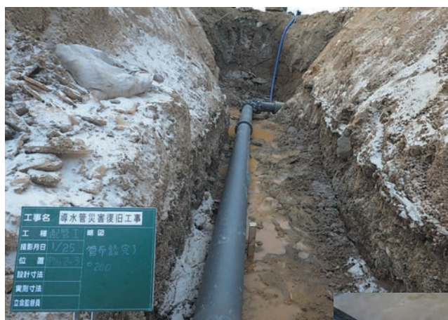
写真9 呼び径200 GX形布設状況
