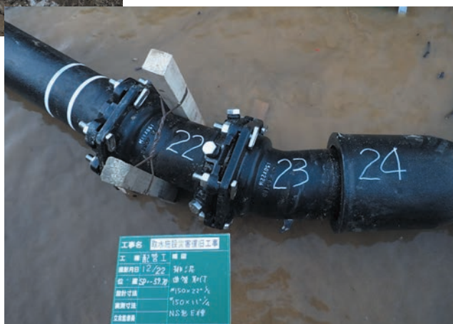
写真10 呼び径150 NS形(E種管)布設状況
