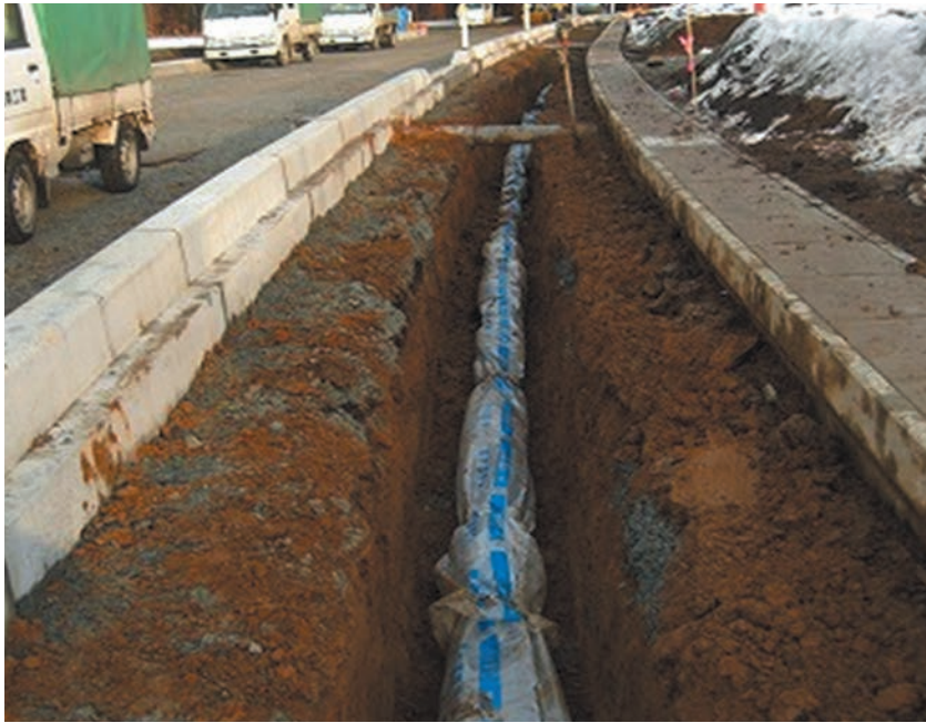
写真4 曲線配管
