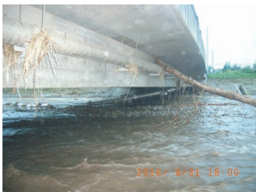
写真5 呼び径75鋼管の状況①
