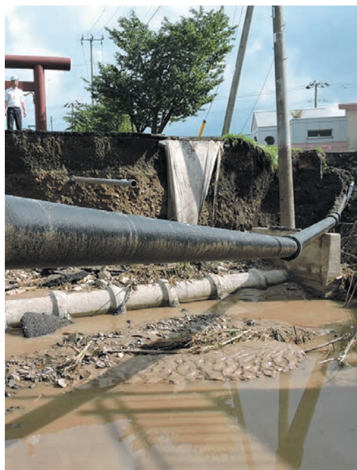
写真8 道路が流されても耐える 呼び径200 NS形ダクトイル鉄管②
