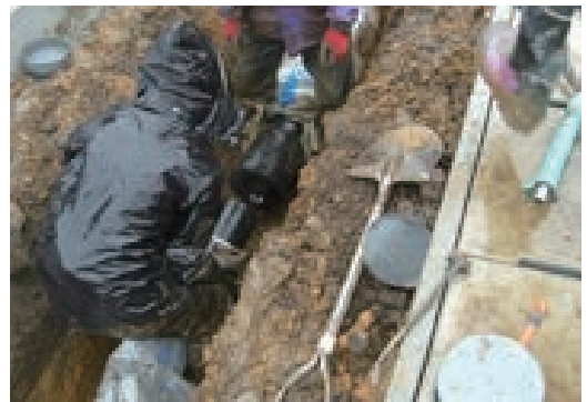
写真2 NS形E種の雨天時の接合
