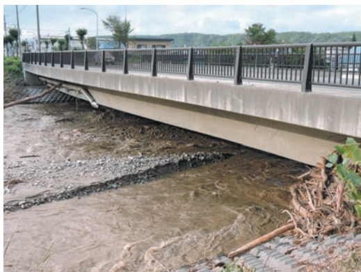
写真6 呼び径75鋼管の状況②
