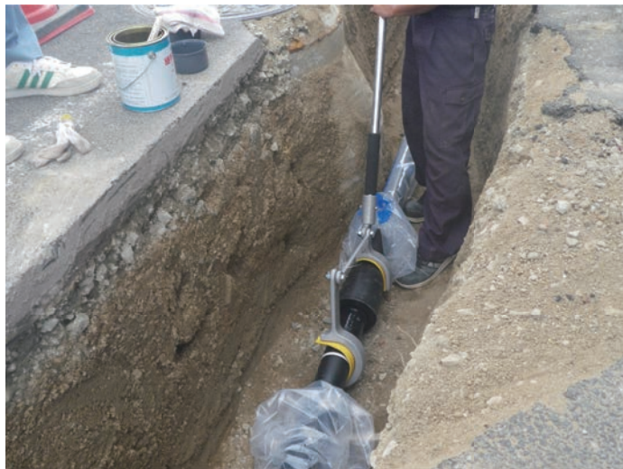
写真1 NS形E種管の施工状況
