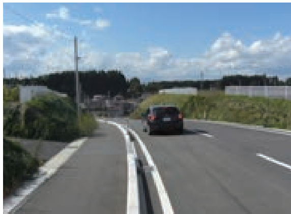
写真3 道路の曲線部
