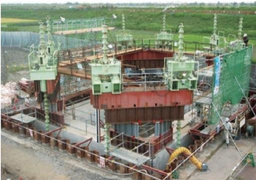
写真2 ケーソン沈設状況
