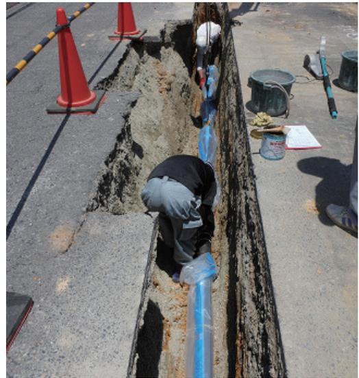
写真1 NS形E種管の施工状況写真
