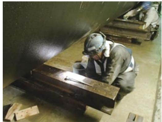
写真7 管受台施工状況
