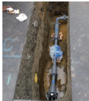
写真 2 S50形ダクタイル鉄管の施工状況
