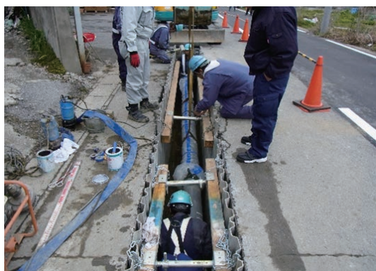
写真2 耐震管への布設替え工事
