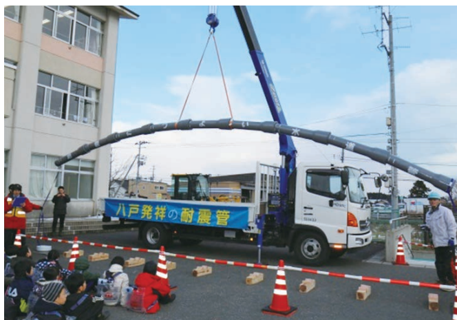
H28年度企業団防災訓練 耐震管を吊り上げ 「八戸発祥の耐震管」をアピール H28.12.15
