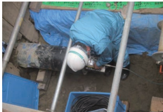
写真 7 カメラ挿入状況
