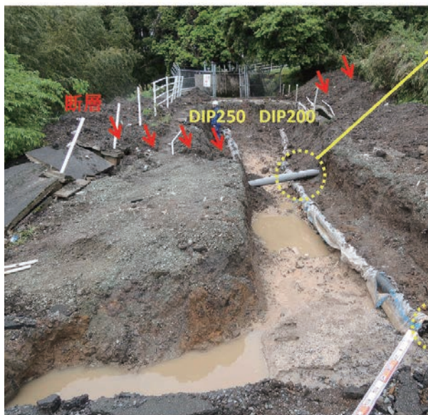
図8 断層横断部の管路被害状況(西原村小森) ＜呼び径200A形ダクトイル鉄管＞
