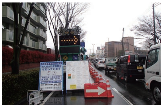
写真2 交通規制状況
