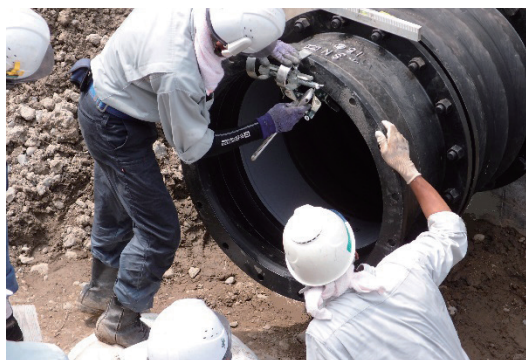
写真1 継手施工状況
