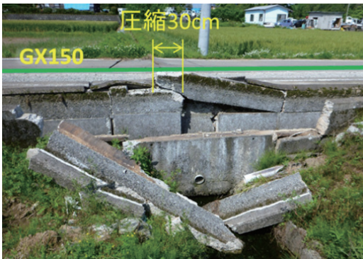
写真5 耐震継手ダクタイトイル鉄管の布設場所(嘉島町) ＜呼び径150GX形ダクタイトイル鉄管＞
