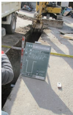
写真2 施工状況 (掘削幅50cm)
