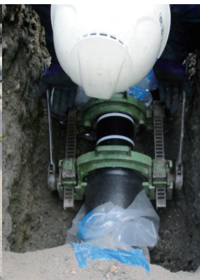
写真3 施工状況 (NS・ジャッキ)
