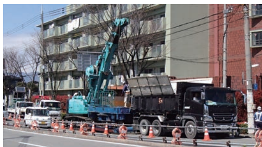
写真1 立坑築造状況
