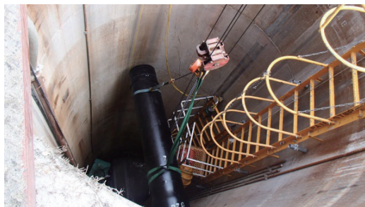
写真3 PN形管吊降し状況
