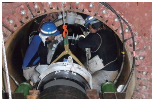
写真4 PN形管継手状況
