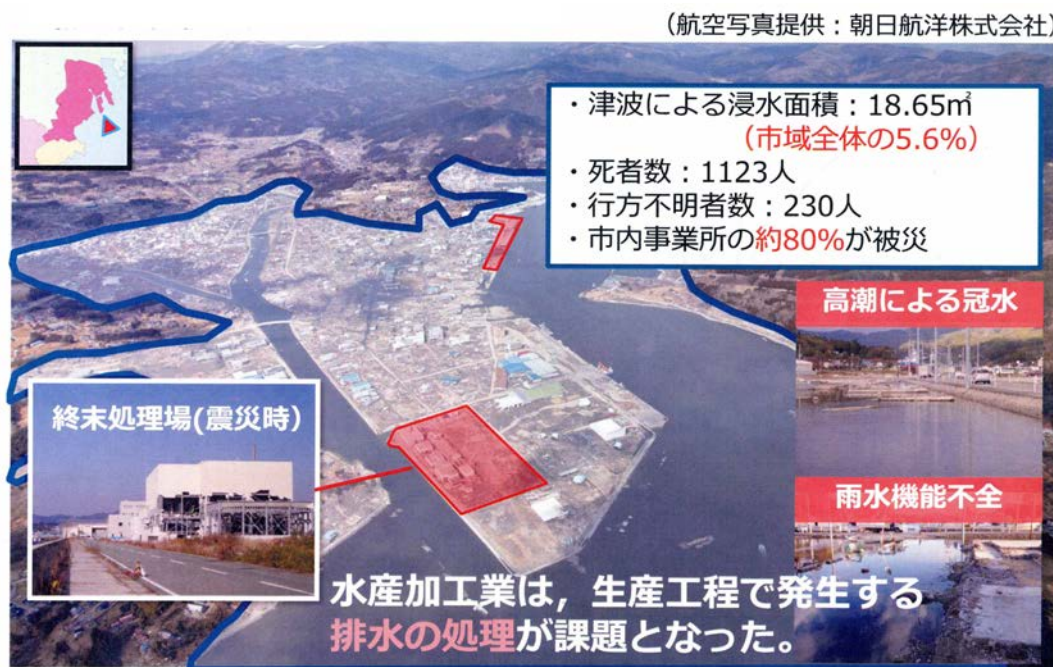
図1 被害状況について
