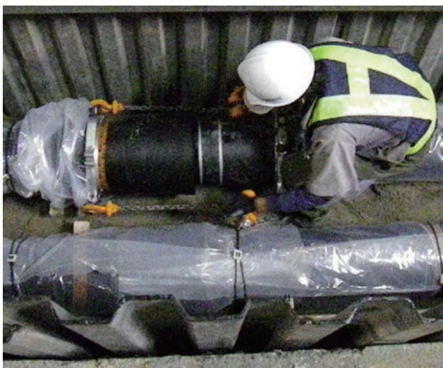
写真2 継手施工状況
