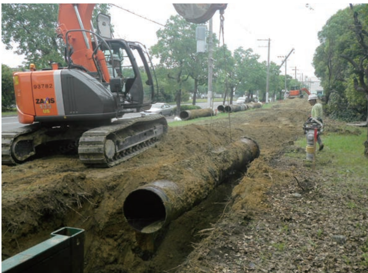
写真5 管撤去状況
