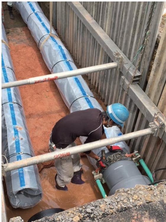
静岡県・牧之原市建設部水道課 GX形 呼び径400・NS形 呼び径 350
