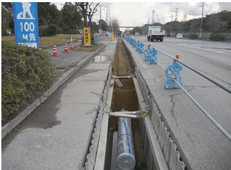
写真1 現場規制状況
