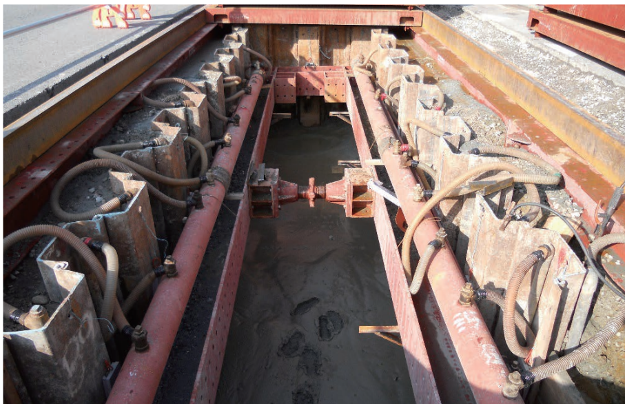
写真4 ウエルポイント施工状況
