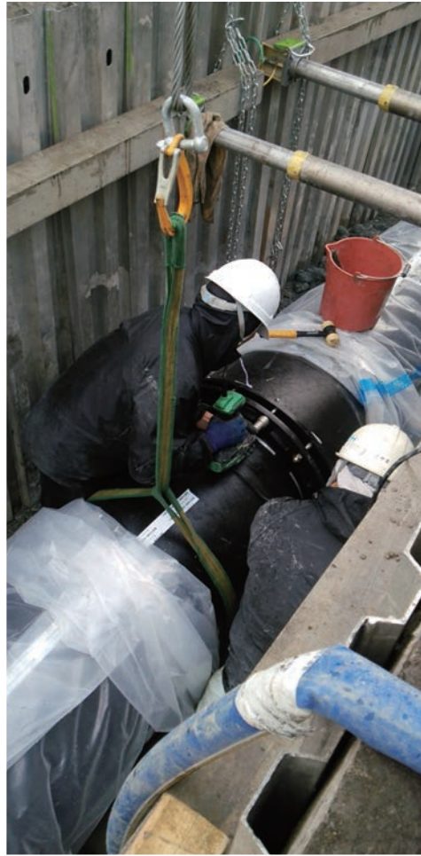
写真3 継手施工状況
