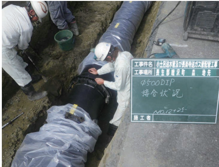
写真1 K形継手接合状況
