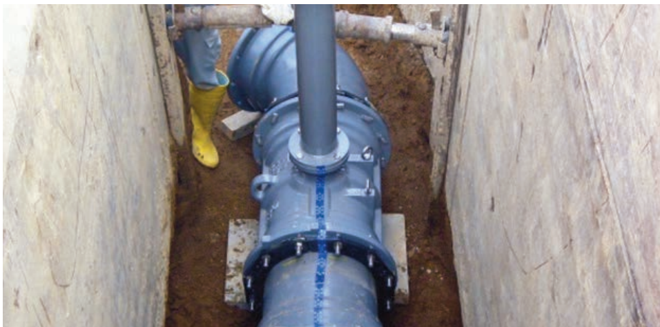
写真5 布設状況 直管→仕切弁→異形管
