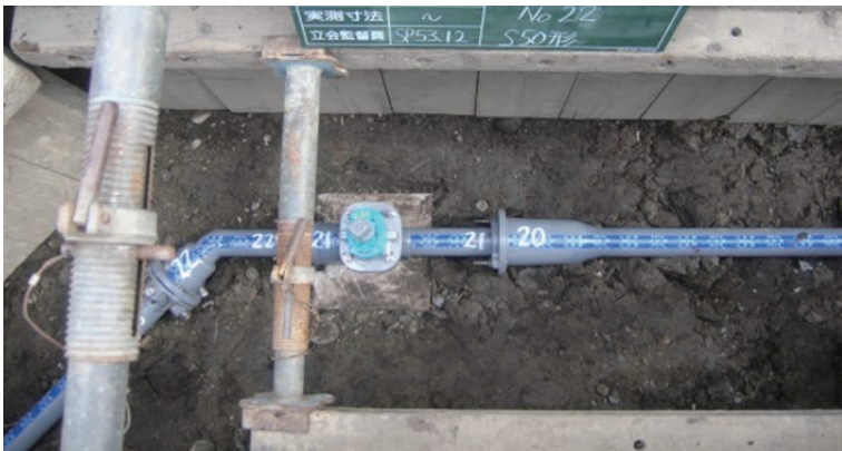
写真9 呼び径50 管布設状況
