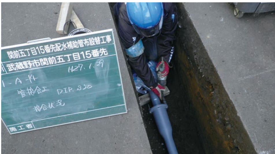
写真3 S50形施工写真
