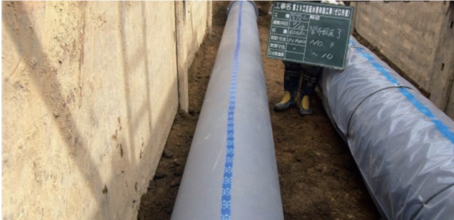
写真6 布設状況 写真左 GX形呼び径400 写真右 NS形呼び径500
