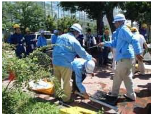
写真1 局職員と組合による仮設給水栓設置訓練
