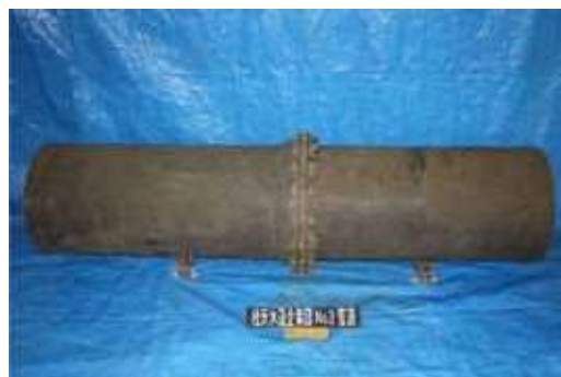
図13 53年間使用された管の外観状況
