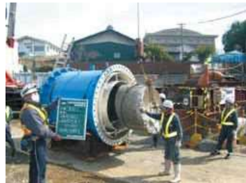
写真4 コンクリート切片引抜状況
