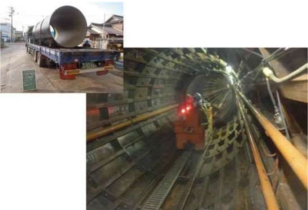
写真2 US形ダクタイル鉄管搬入状況
