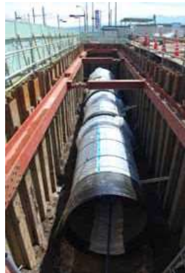
写真4 耐震性貯水槽設置
