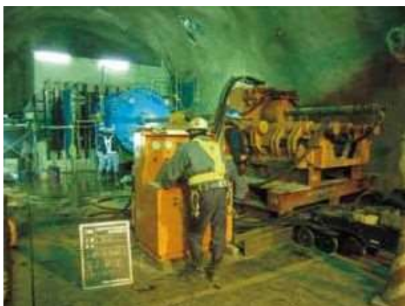
写真3 分岐部施工状況
