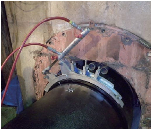
写真6 PN形 接合状況(ロックリング挿入)
