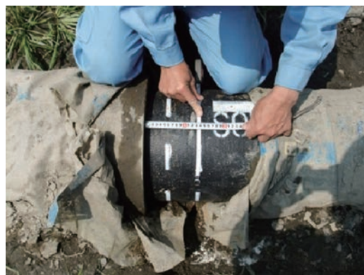
写真7 管外面からの調査状況
