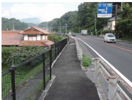
写真1 工事施工場所
