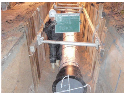
写真2 工事施工状況
