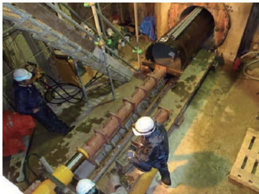
写真11 PN形管挿入状況②
