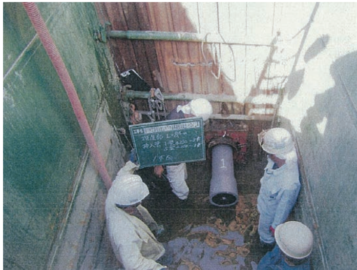
写真1 さや管推進施工状況
