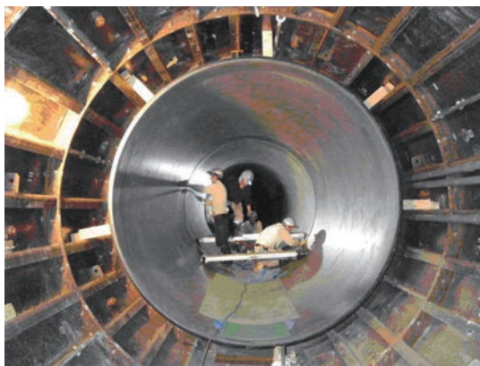
写真4 配管されるダクタイル鉄管
