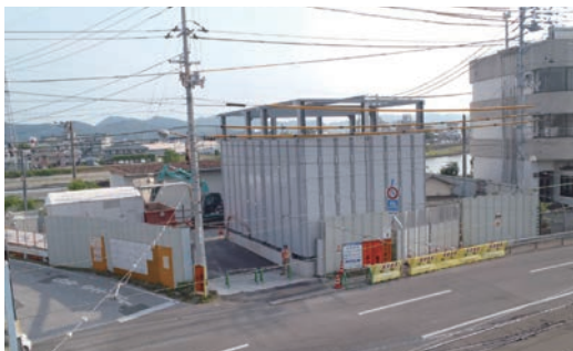
写真2 発進基地全景
