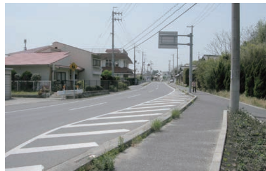
写真3 震源付近(五色町)の状況 (地盤変状や液状化等の痕跡なし)
