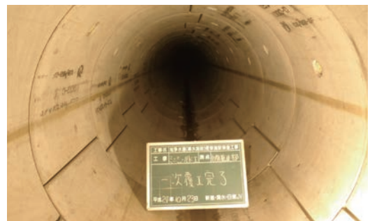
写真4 1次覆工(シールドトンネル)完了
