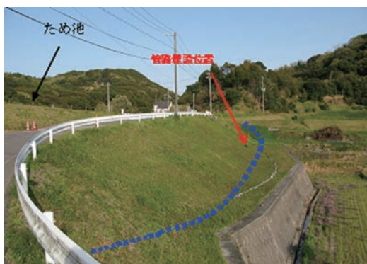
写真2 耐震管路の埋設箇所 (呼び径300SⅡ形、被害なし、淡路市木曾上)
