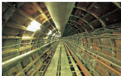
写真1 シールド一次覆工
