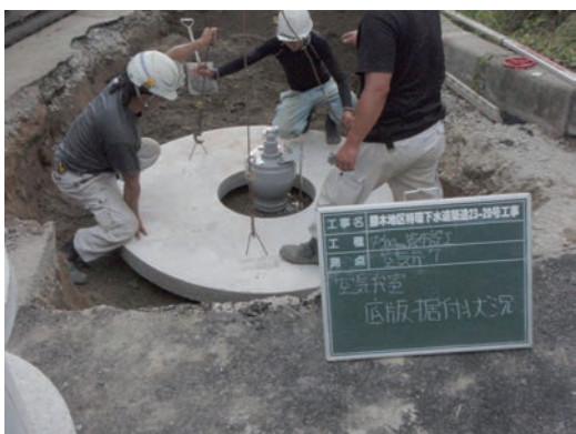
写真3 下水道用空気弁設置状況
