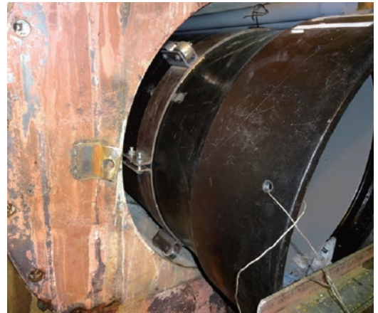
写真9 キャスター付バンド取付状況
