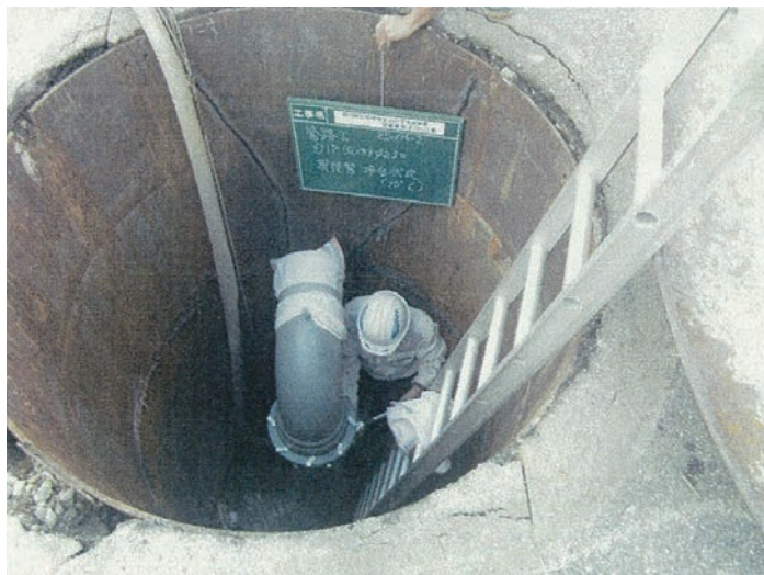
写真2 到達立坑内の配管状況
