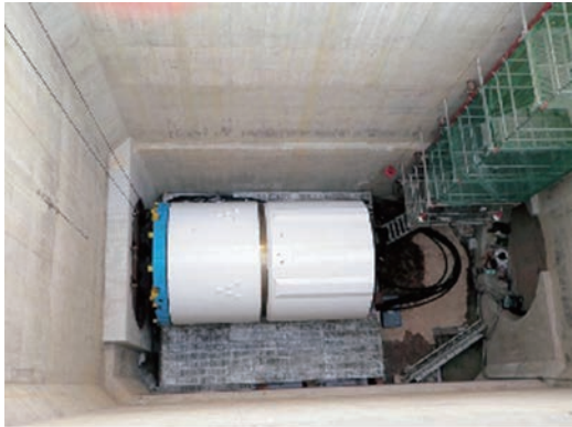
写真2 立杭およびシールドマシン
