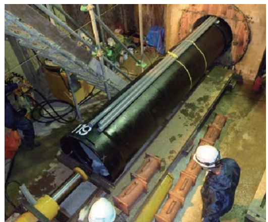
写真10 PN形 管挿入状況①
