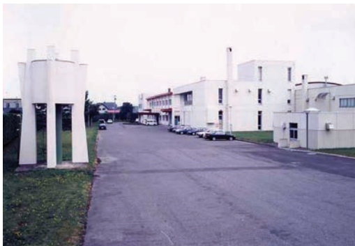
● 石狩川浄水場
