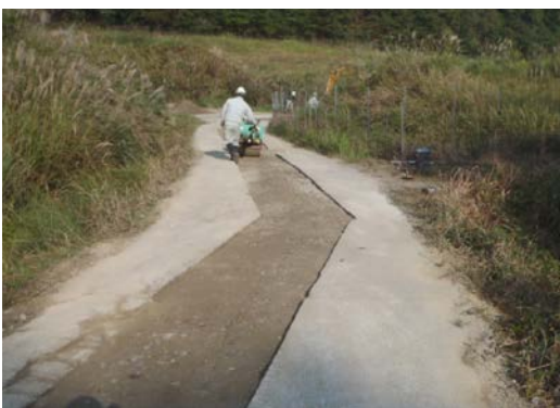
写真1 現地の状況①
