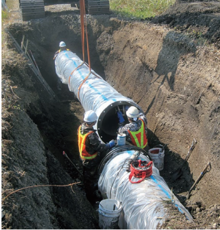
北海道 稚内市水道部 NS形 呼び径 700
