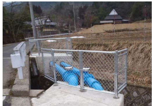
写真6 施工写真(水路横断)
