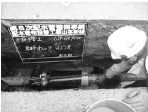
写真3 GX形直管接合状況
