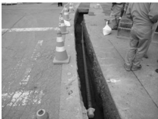
写真4 GX形布設状況
