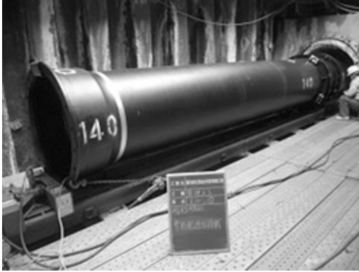
写真4 NS形ダクタイトイル鉄管の推進状況(スパン1側)
