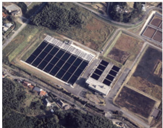
●井手浦浄水場
