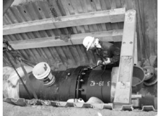
写真3 ダクトイル鉄管S形呼び径900布設状況
