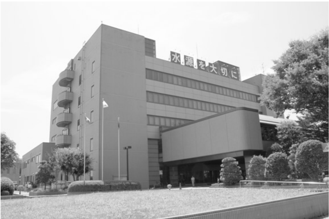
●仙台市水道局庁舎
