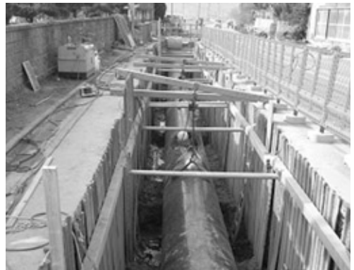
写真5 鋼管呼び径1000の布設状況
