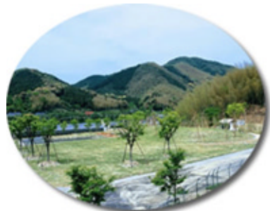
●やまめの里全景(井手浦浄水場)
