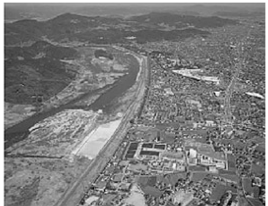
写真1 西阿知浄水場周辺
