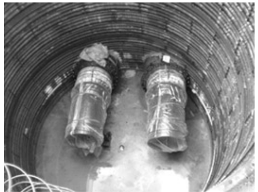
写真6 到達立坑(推進完了後)
