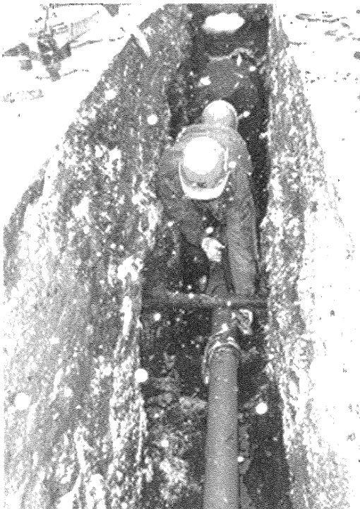
写真2 直管の接合作業
