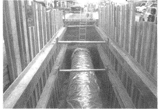
●水道耐震管の布設
