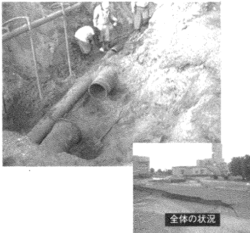
写真6 軟弱地盤での呼び径400K形継手の抜け
