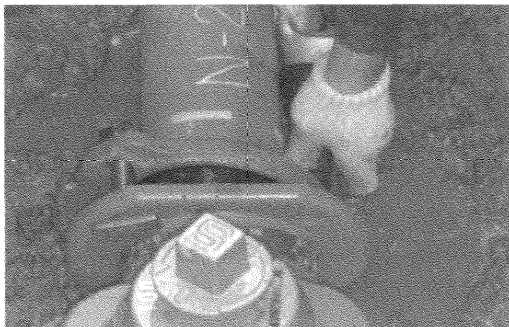
写真5 GX形異形管接合
