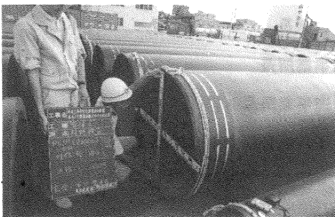
写真2 呼び径1000mm、700mmダクタイトル鉄管の布設
