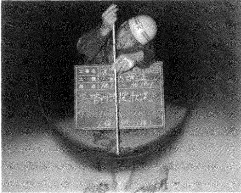
写真2 管内調査状況
