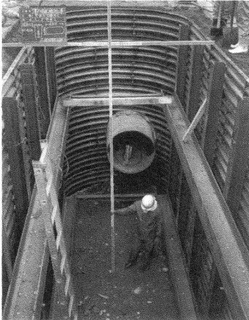
写真1 ライナープレートを使用した立坑
