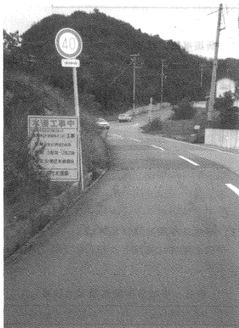
写真3 呼び径500mm布設替え道路
