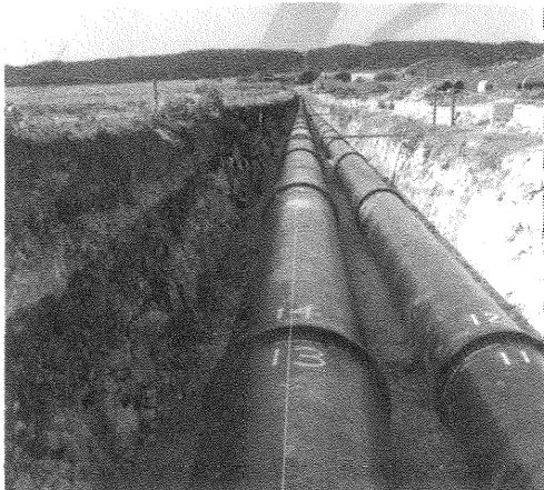
写真2 呼び径1000mm、700mmダクタイトル鉄管の布設
