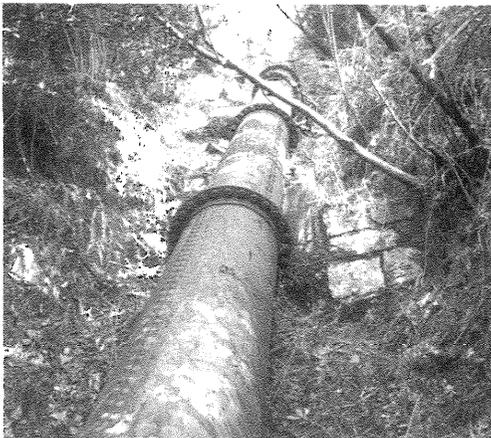
鋼管は山腹での露出配管のため、近年腐食による孔あきが多く取水量にも影響が出始めたため、ダクタイトル管に取り替えることとした。今回はこの急傾斜地配管の事例について報告する。
