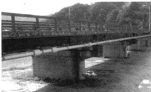
架設、接合し、継手部も含め管周囲に保温材を巻きつけた。(写真2参照)
