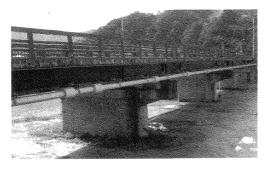
架設、接合し、継手部も含め管周囲に保 温材を巻きつけた。(写真2参照)
