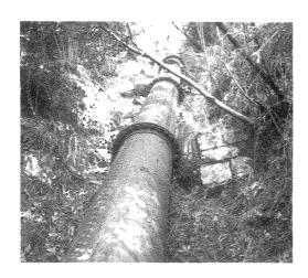
鋼管は山腹での露出配管のため、近年腐食による孔あきが多く取水量にも影響が出始めたため、ダクタイル管に取り替えることとした。 今回はこの急傾斜地配管の事例について報告する。
