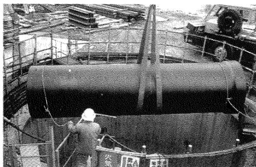
写真5 台車への管吊りおろし状況
