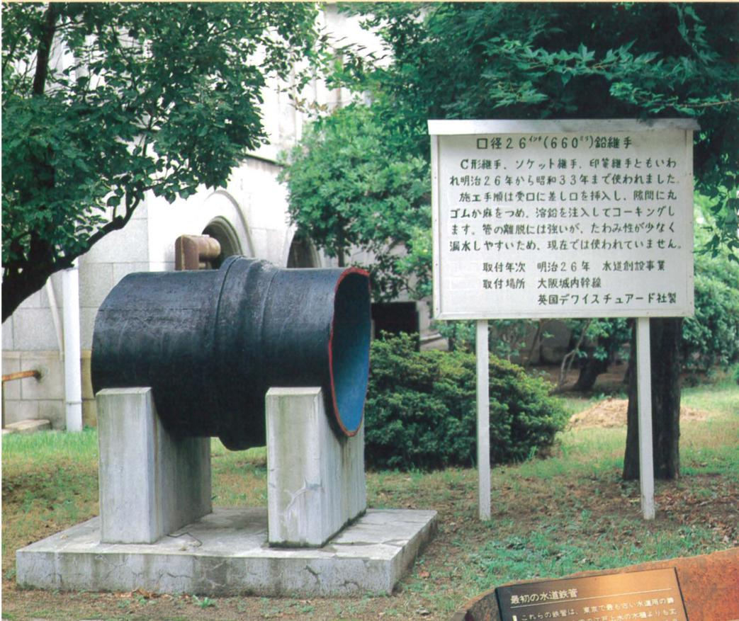
口径26<sup>1/2</sup>"(660<sup>mm</sup>)鉛継手
