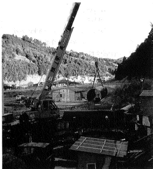
ドに一時仮置きし、そこからトンネル内に運搬する。坑口よりトラッククレーンを使用して、管をナイロンスリングによる2点吊りでもり上げ、トンネル入口のバッテリーロコにけん引された管運搬台車に吊りおろす。積み込みを完了した台車は2km/時程度の安全な速度で、配管据付け場所まで管を搬送する。
