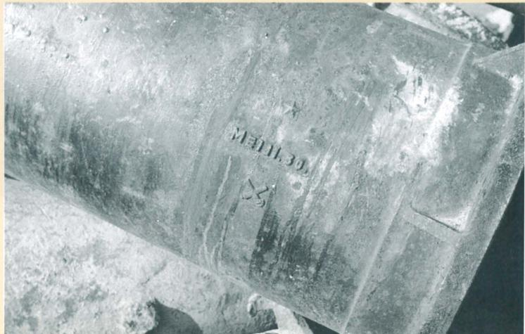
名古屋市で使用されていた、明治45年(1911年)に久保田鉄工で製造された36インチ(呼び径900mm)鑄鉄管。名古屋市章の㊦マークが鑄出しされているのが見える。
