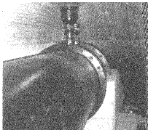
写真—9 曲管部受台(傾斜面頂部)
