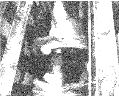
写真一5 管受口、挿し口清掃
