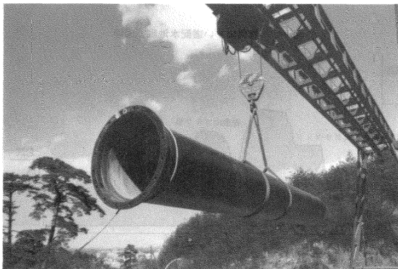
写真－3 下口工区立抗よりの管吊り下ろし状況
