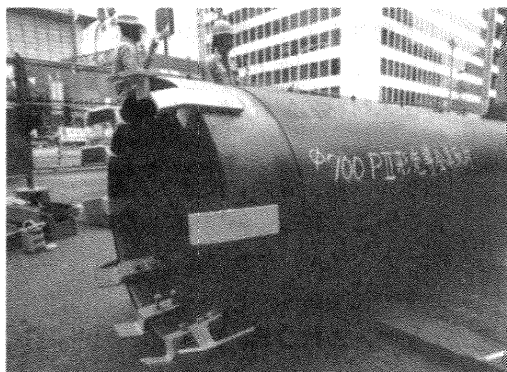
写真-6 先導金具取付け
