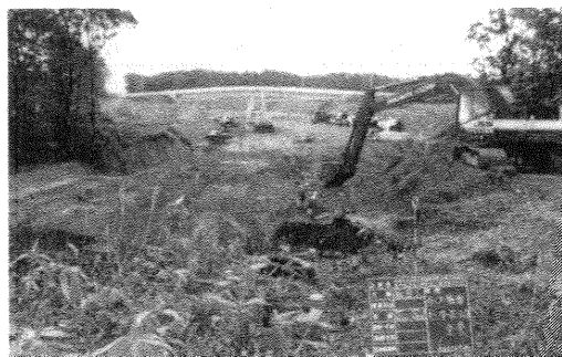
写真-4 チェックボーリングの状況
