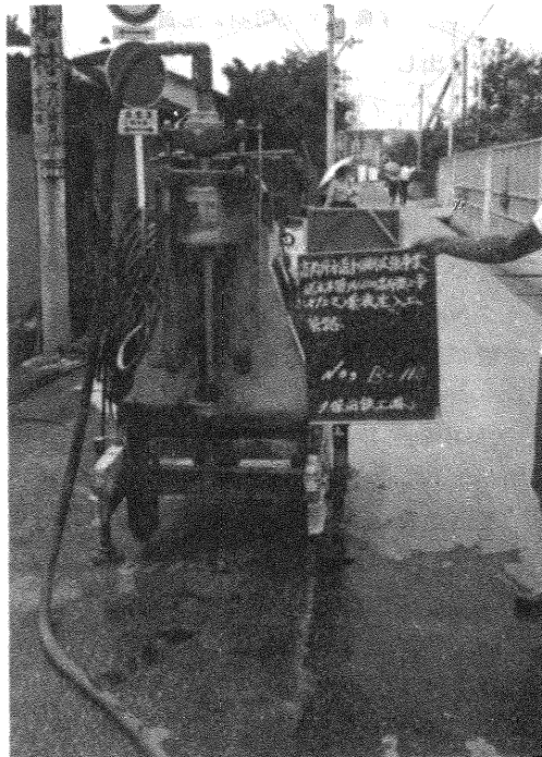
写真-7 地盤改良
