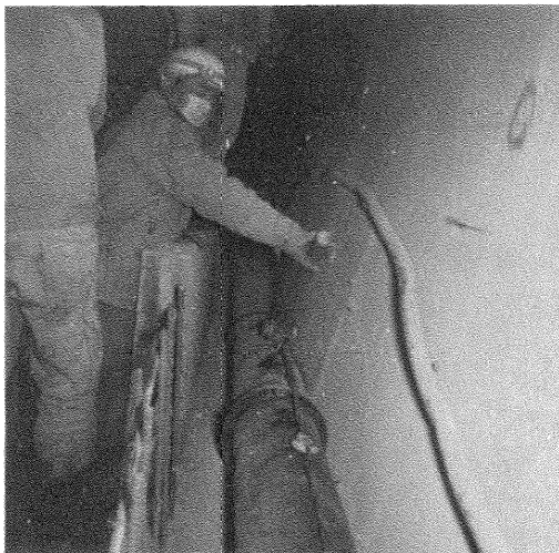
写真-5 鑄鉄管布設状況
