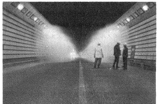
写真四 水噴霧状況
