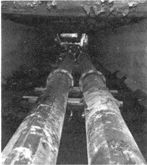
写真-2 送泥管の布設状況
