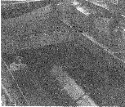
写真-4 管の接合作業
