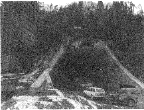
写真一 完成近い東坑口
