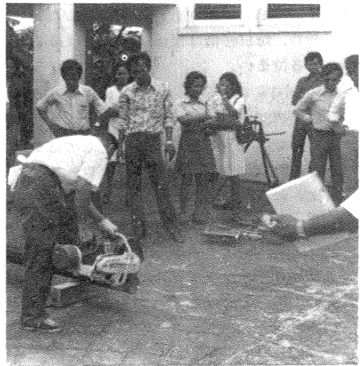
写真－9 配水管実技指導実習（エンジンカッターの威力にびっくり「そんなに早く切らなくともいいのに……」）
