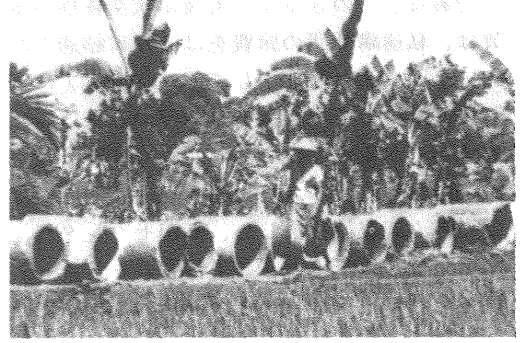
写真一六 現場製の鉄筋コンクリート管（スラバヤ郊外の送水管布設現場で）
