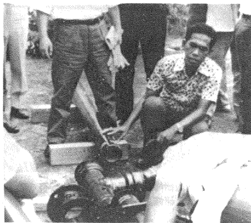
写真一 7 配水管実技指導実習
