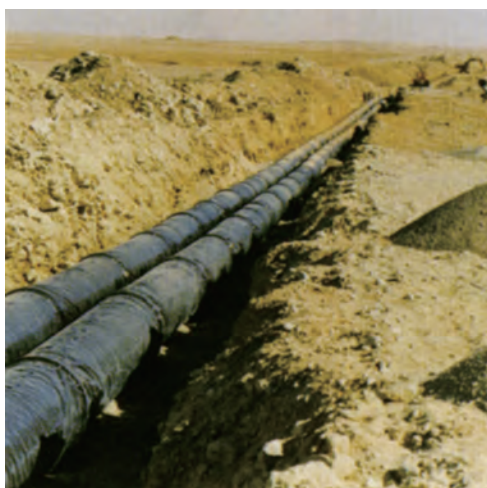
サウジアラビアの上水道管 (T形呼び径 1100 ダクタイル鉄管)
