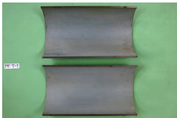
39年間使用された粉体塗膜 (異常認められず良好、呼び径200直管)
