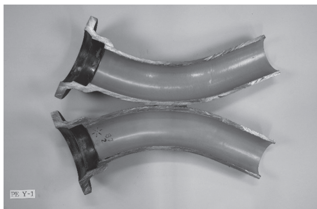
写真6 30年間使用された粉体塗膜 (異常認められず良好、呼び径100 45° 曲管)
