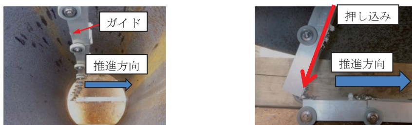
写真4 逆方向屈曲状況
