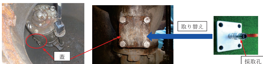
写真2 空気弁に設置された蓋と採取孔設置の例
