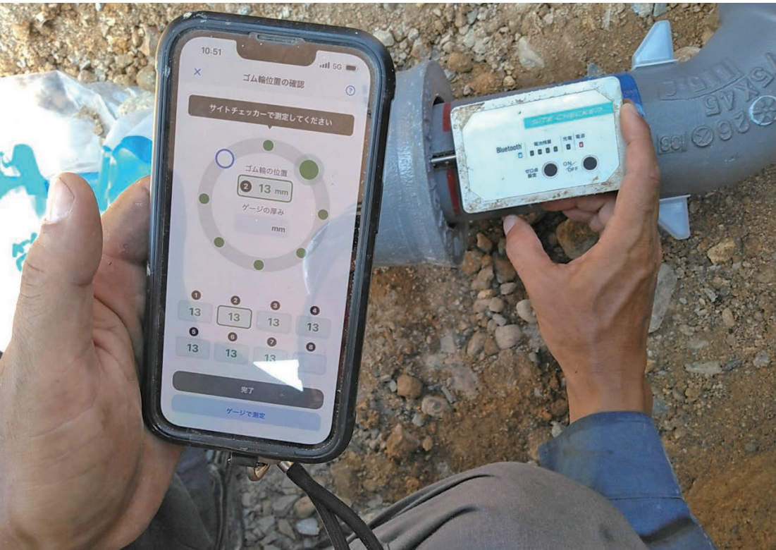
写真3 施工管理システム利用状況(ゴム輪位置確認)
