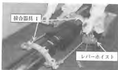
図15 レバーホイストを用いた接合例1 (呼び径75～250)
