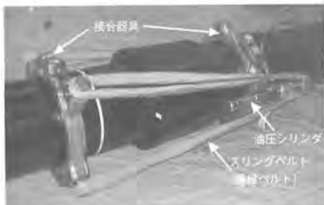
図17 油圧機器を用いた接合例(呼び径300~450)
