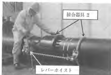
図16 レバーホイストを用いた接合例2 (呼び径75～450)
