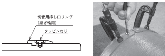
図90 タッピンねじの締め付け
