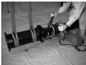
図45 継ぎ輪の先行管への引き込み
