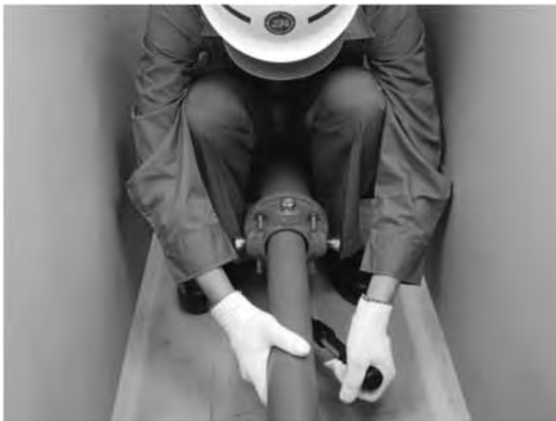
写真2 抜け止め押輪 施工性試験状況
