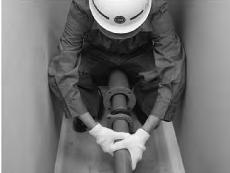
写真1 直管 施工性試験状況
