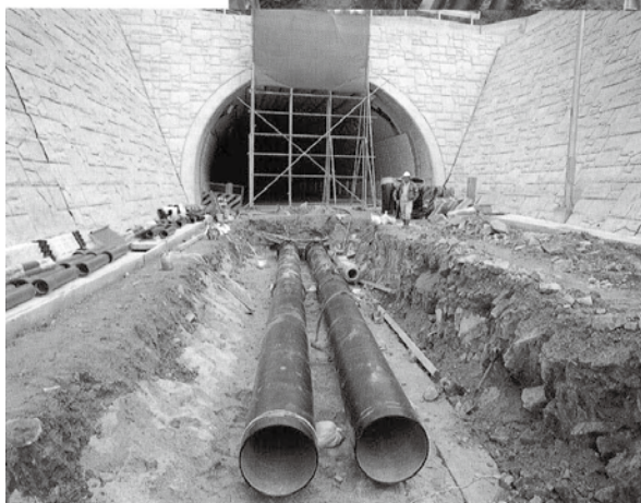
汚水圧送幹線(並列配管)に 使用されている呼び径600 ダクタイル鉄管
