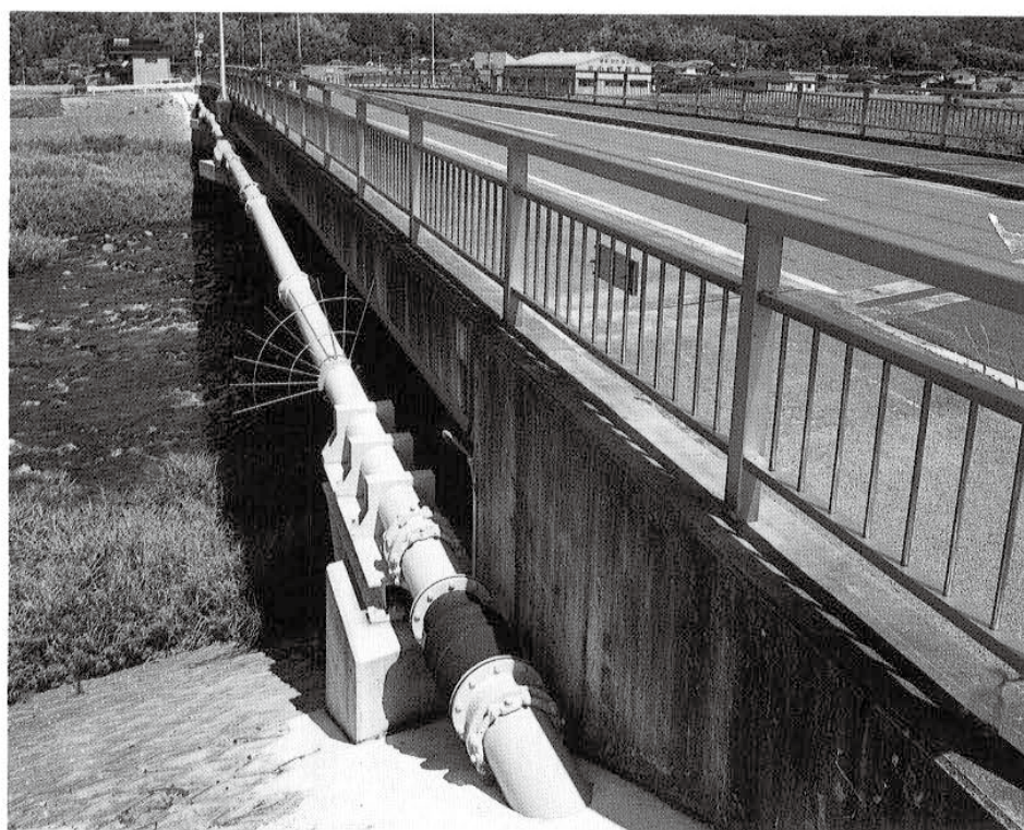
汚水圧送管の水管橋に使用されている呼び径300ダクタイル鉄管
