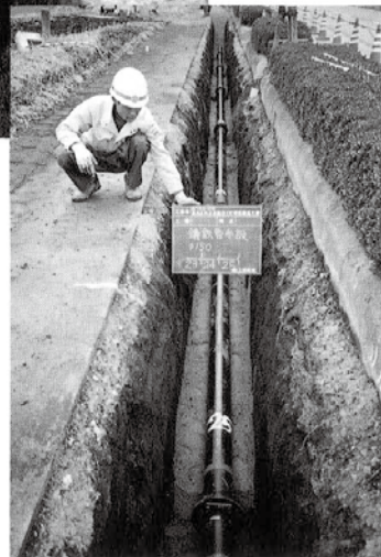
マンホールポンプ形式による 長距離圧送管に使用されている呼び径 150ダクタイル鉄管
