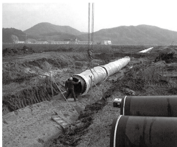
浄化センター内放流管に 使用されている 呼び径1350ダクタイル鉄管
