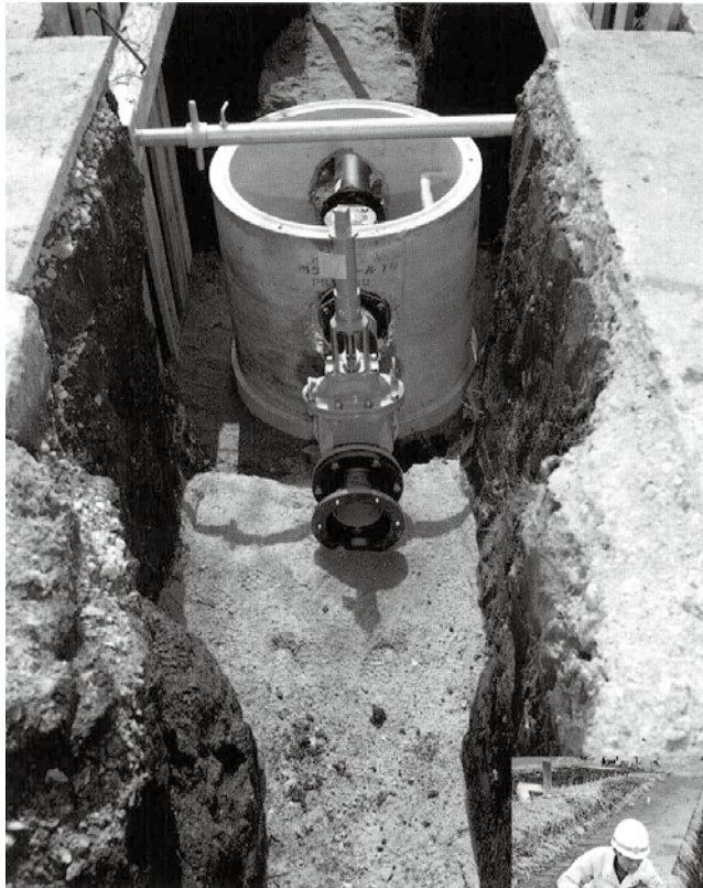
マンホールポンプ形式による 長距離圧送管に使用されている呼び径 150ダクタイル鉄管
