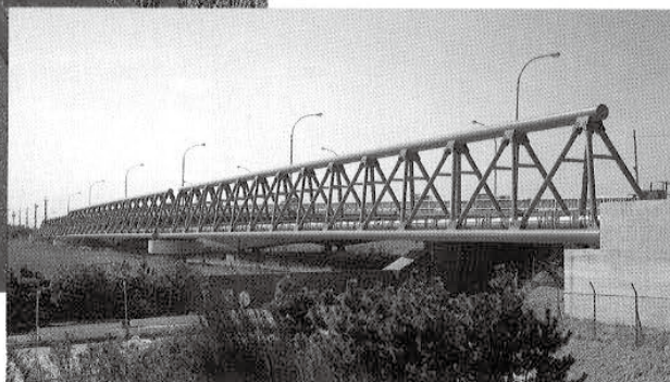
下水専用橋 (汚水圧送管) に使用されている呼び径 600ダクタイル鉄管
