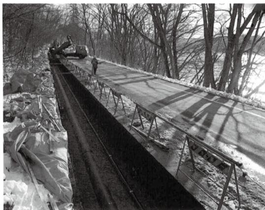
特定環境保全公共下水道に 使用されている 呼び径350ダクタイル鉄管
