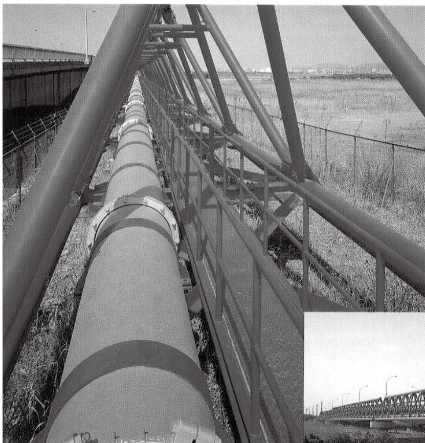
下水専用橋 (汚水圧送管) に使用されている呼び径 600ダクタイル鉄管
